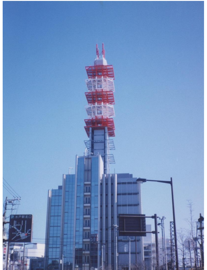
ドコモ水戸ビル（製作，めっき，塗装施工）
