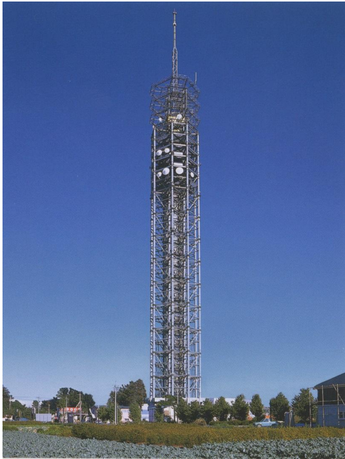
西東京スカイタワー（製作より施工）
