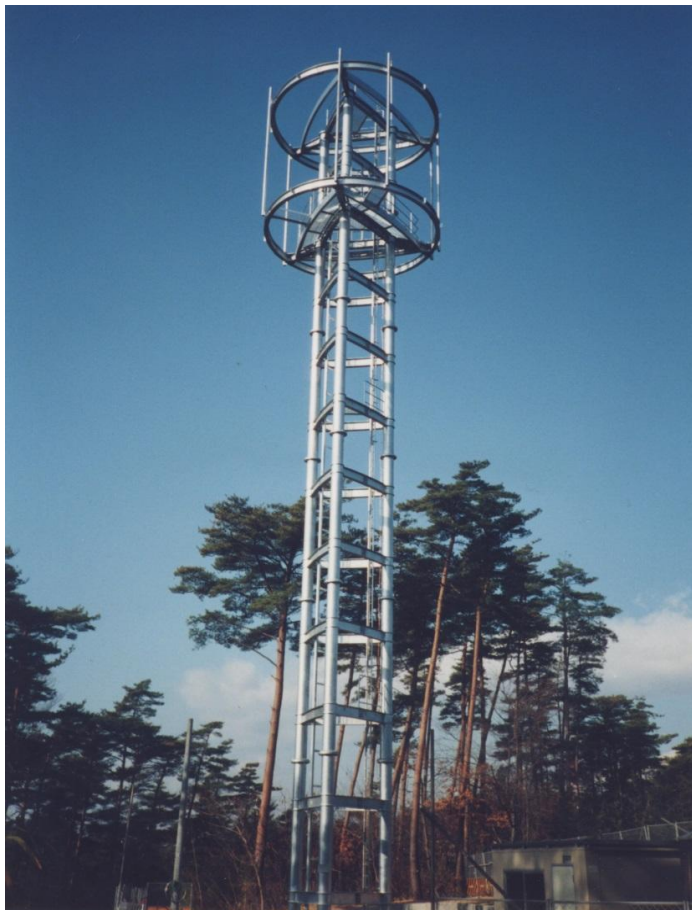
移動体通信無線鉄塔（製作より施工）
